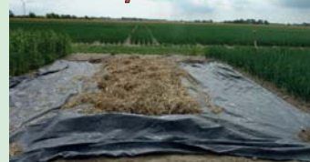
Stap 1: Aanbrengen biomassa
